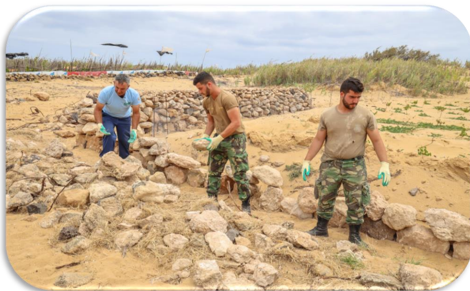
Construção dos muros de croché
